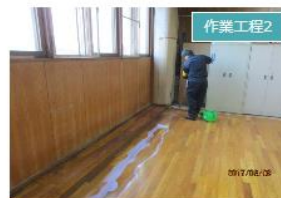
武道館ウレタン塗装作業
