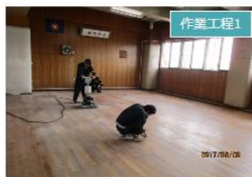
武道館床研磨作業
