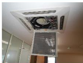
天井付型エアコン清掃
