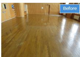
木床再生作業前
