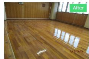
武道館ウレタン塗布作業終了後
