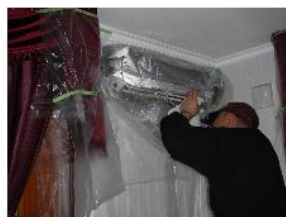
壁付型エアコン清掃作業中
